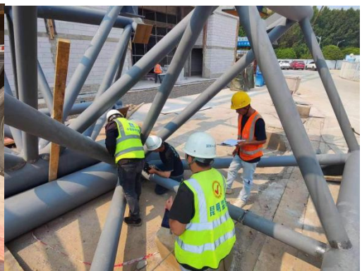
体育馆钢桁架焊缝检测
