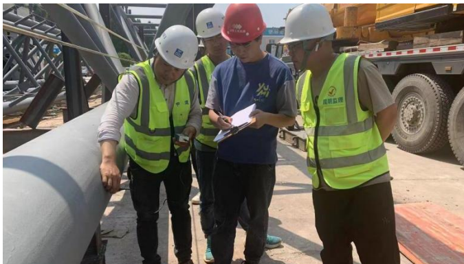
体育馆钢桁架防腐漆厚度、相贯口焊缝检测
