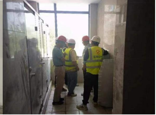
卫生间隔板样板现场对接
