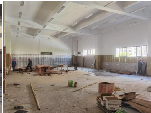
吸音墙面板安装
