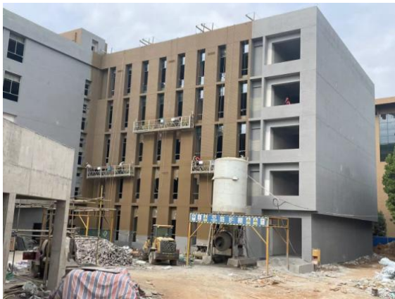
外墙涂料施工
