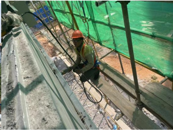
外墙铝单板预埋件施工
