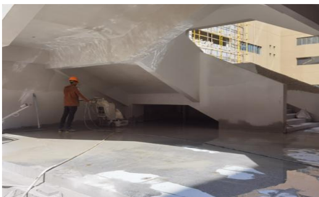
一层水磨石施工
