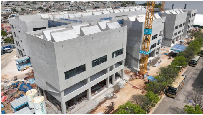
7#教学楼目前现场整体航拍图
