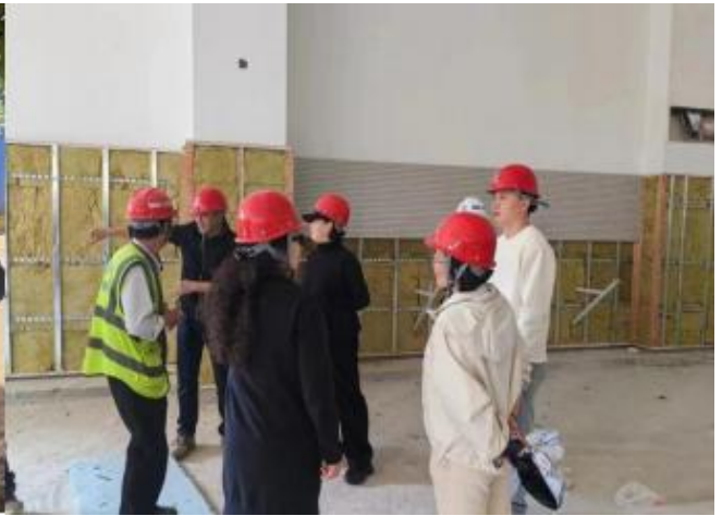
舞蹈学院考察现场施工情况
