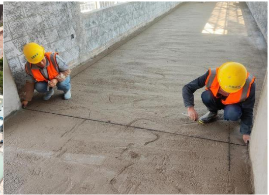
教学楼水磨石弹线
