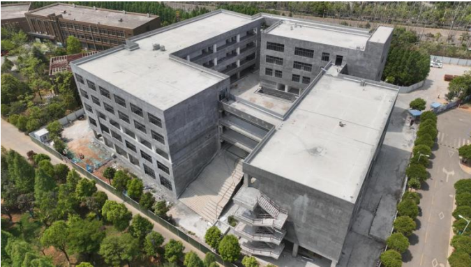
4#教学楼目前现场航拍图
