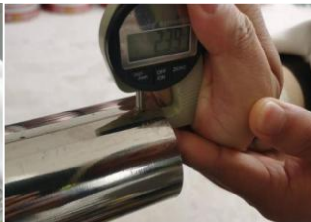
不锈钢栏杆进场验收
