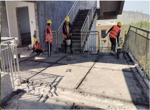
楼梯水磨石施工
