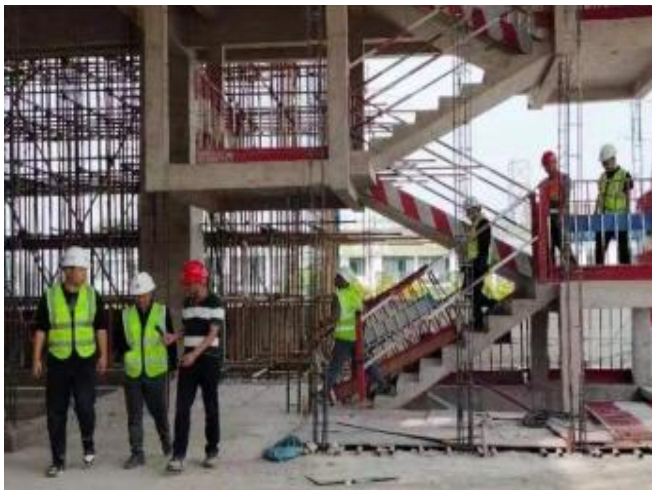
每周现场安全检查
