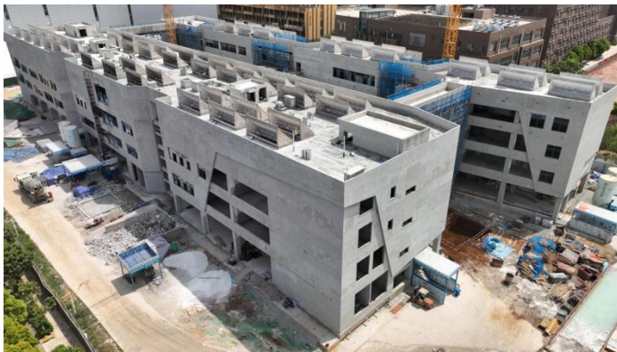
7#教学楼目前现场整体航拍图
