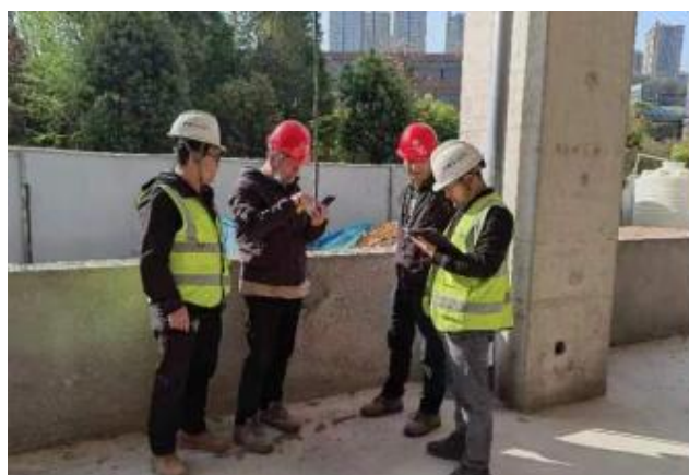
室外周边雨水管网现场排查
