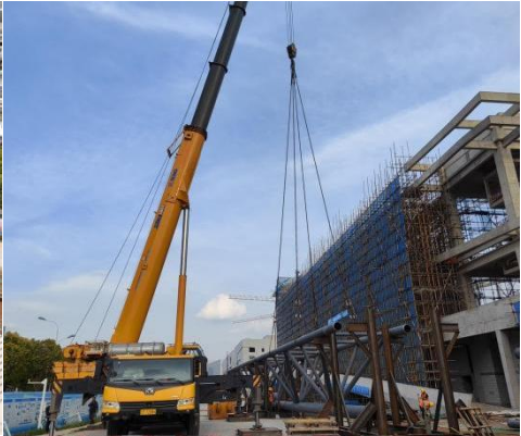
体育馆主桁架拼装
