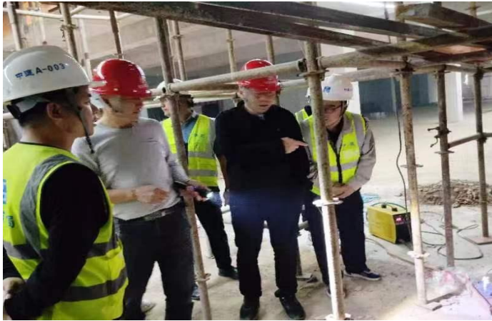
每周现场安全检查
