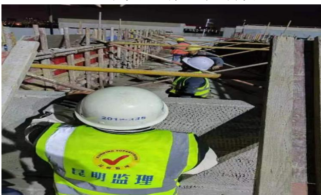
夜间浇筑巡检
