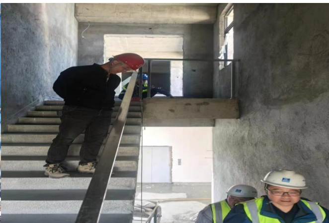
栏杆安装过程检查
