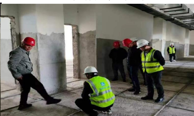
水磨石施工过程检查
