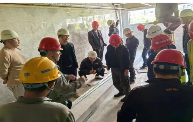
现场卫生间贴砖样板确认
