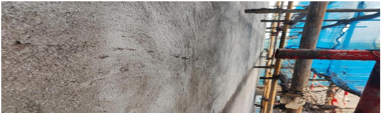
4#教学楼4-3区外墙抹灰完成80%
