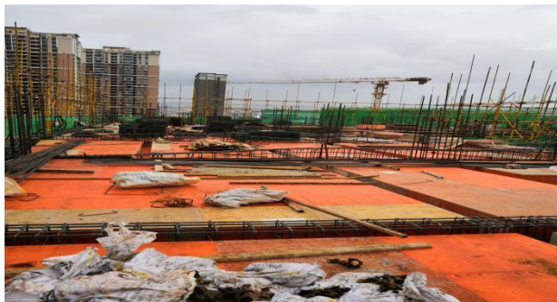
剧场音乐厅（1#2#教学楼）
