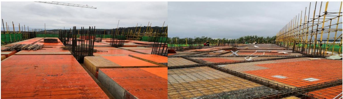
剧场音乐厅（1#2#教学楼）
