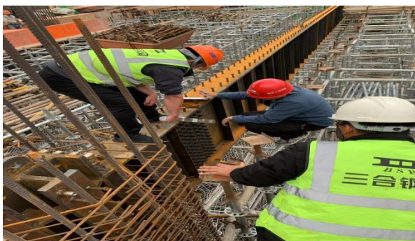
抽检高强螺栓连接终拧扭矩检测
