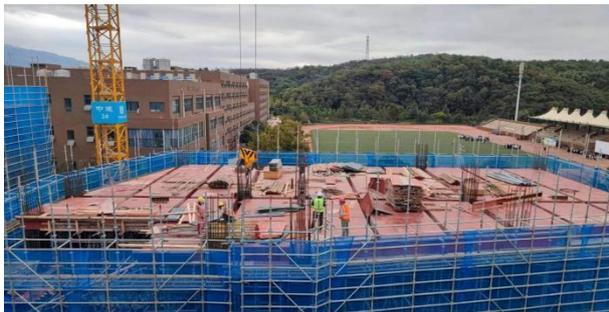
7-4区东区屋面开始绑扎钢筋、西区屋面模板安装80%
