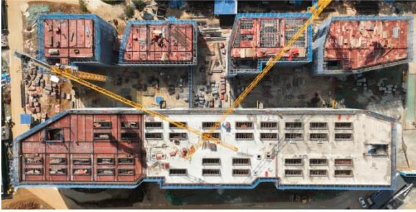
7-1、7-2区屋面混凝土浇筑完成
