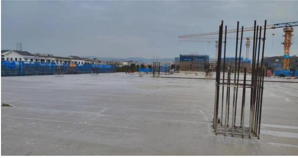
T-1区一层顶板浇筑 完成
