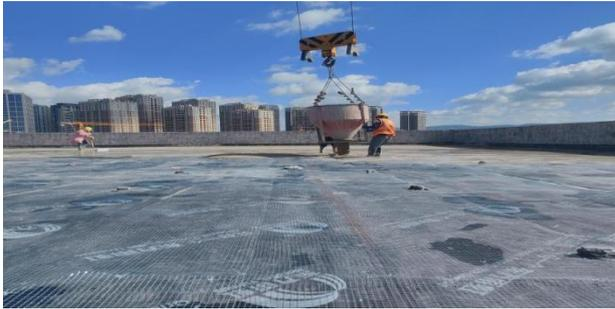
屋面刚性保护层浇筑完成
