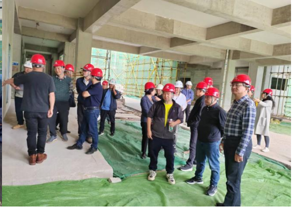
视察样板墙面
