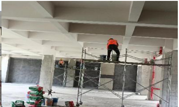
室内顶棚第二遍腻子施工
