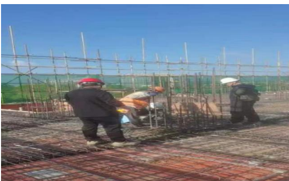
参与现场水电安转验收
