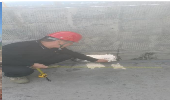
现场巡检屋面防水细部处理
