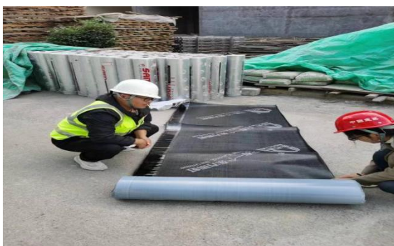
抽检防水卷材现场取样
