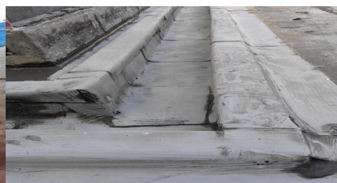
4-4区屋面第二层防水卷材施工
