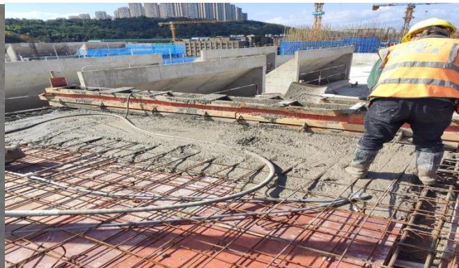
7#教学楼屋面机房浇筑
