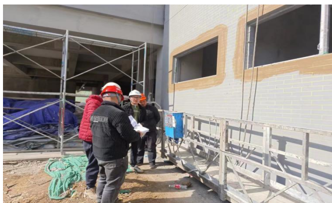
现场吊篮检查验收
