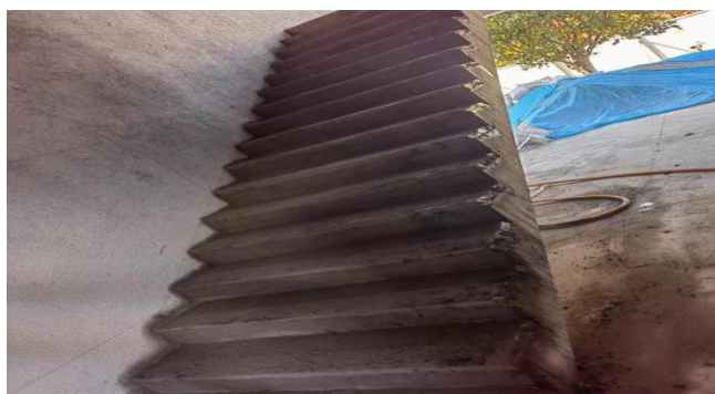
4-2区楼梯找平层浇筑完成
