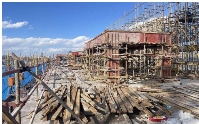
T-2区 屋面机房、楼梯雨棚钢筋及支架、模板安装完成
