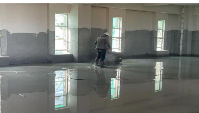
D区水磨石踢脚线施工
