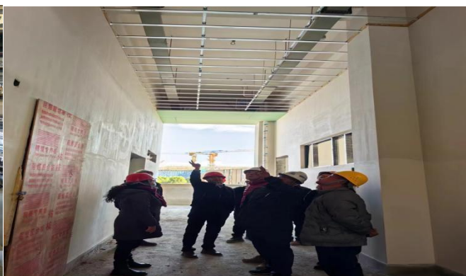
吊顶龙骨基层验收
