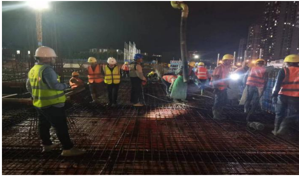
夜间浇筑巡检
