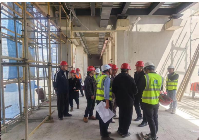
美术学院考察现场施工情况
