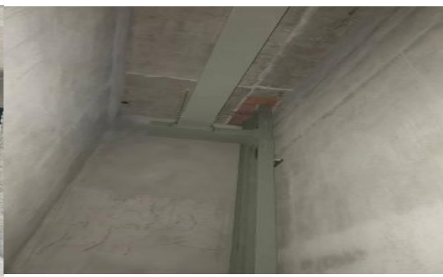
强弱电桥架安装
