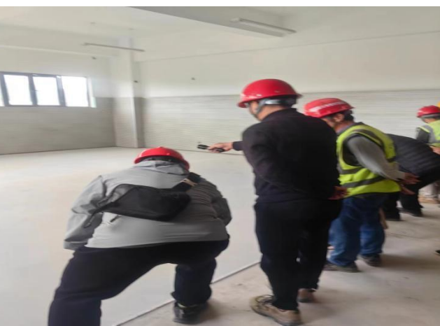
自流平施工检查
