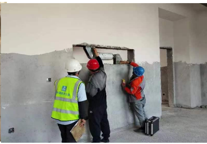
落实第三方阻尼器焊缝检测
