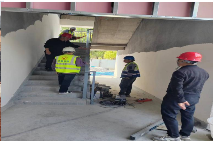
楼梯栏杆安装过程巡检
