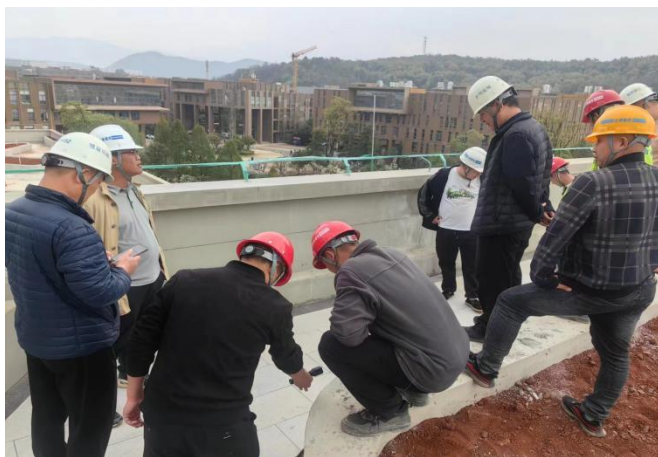
pc砖施工样板检查
