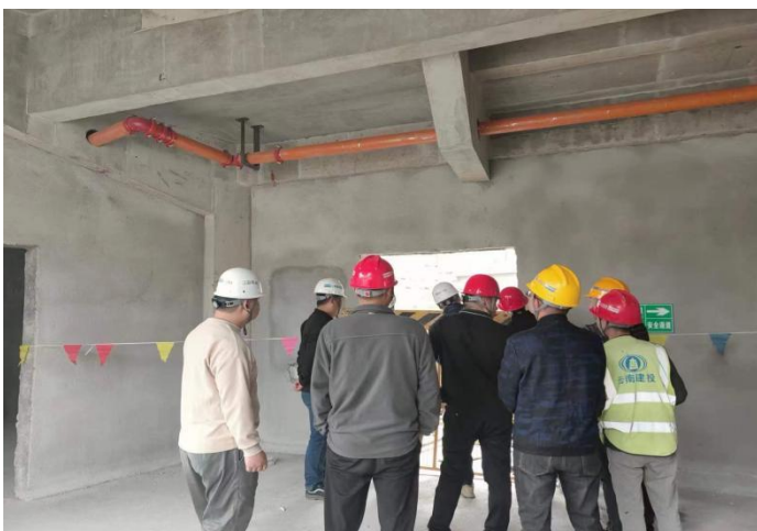
每周现场安全检查
