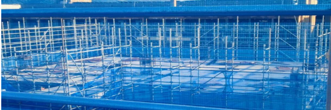
7#教学楼7-5西区三层浇筑完成
