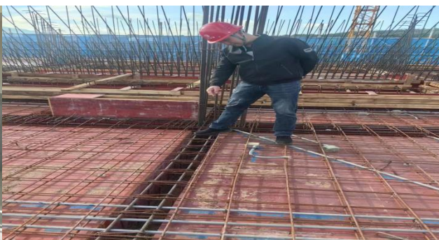
巡查钢筋绑扎质量
