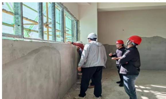
参与窗框样板安装验收
