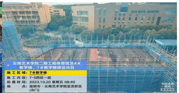
7-5西区一层顶梁板钢筋绑扎完成
