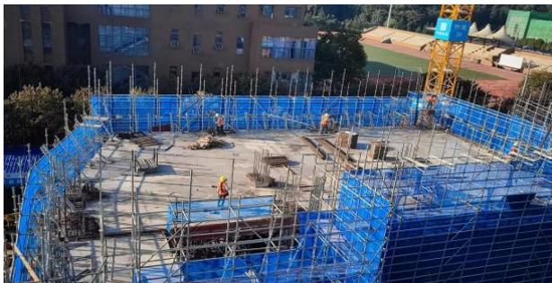
7-4东区二层顶板混凝土浇筑完成，三层柱钢筋绑扎完成10%
