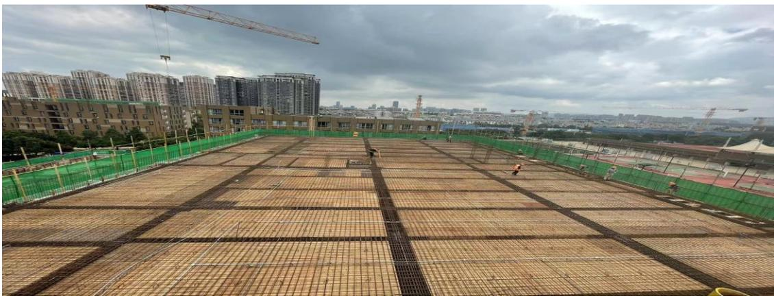
6#教学楼C区二层顶板钢筋安装完成
