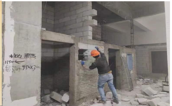
落实砌筑不合格部位返工
