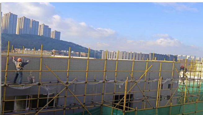
实训用房外墙抹灰施工
