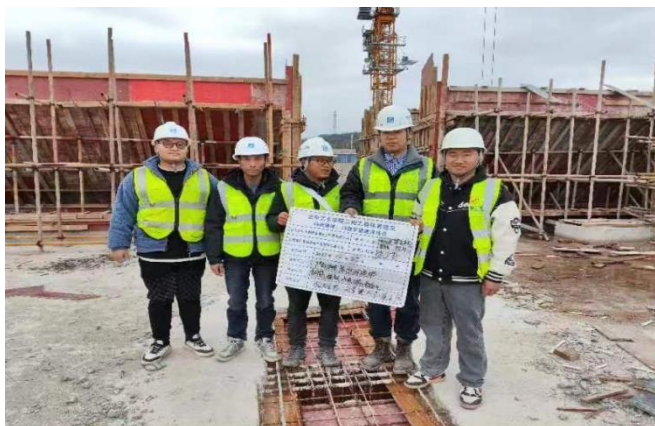
落实现场三检举牌验收制度
