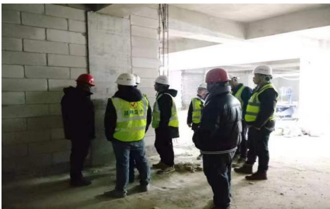
现场砌筑质量检查
