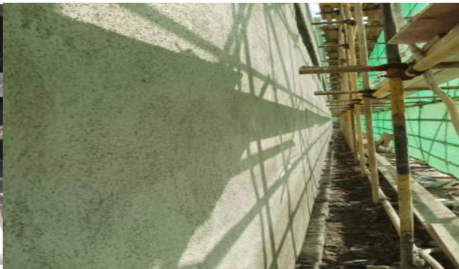
实训用房外墙抹灰施工
