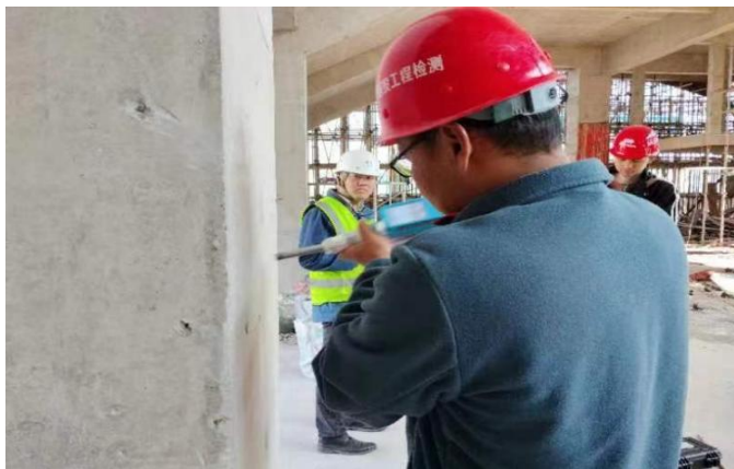
落实主体结构检测
