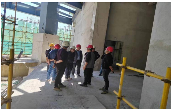
每周现场安全检查
