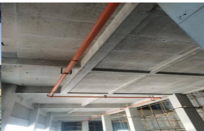
消防管道安装
