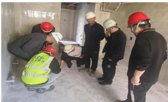
卫生间贴砖样板验收
