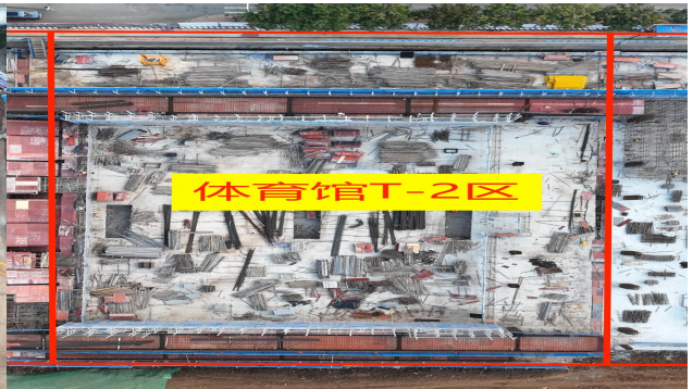
T-2区0.2米层浇筑完成，6米层梁钢筋绑扎完成
