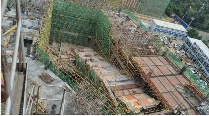
地下室部分低跨四层顶板模板支架搭设，高跨三层顶板钢筋安装
