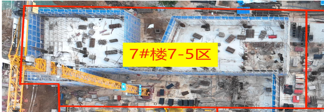
7#教学楼 7-5区二层外架完成
