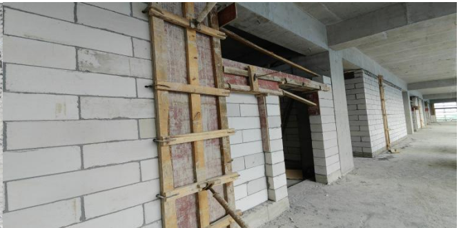
体育馆 T-3西侧6米层内支撑架完成，模板完成，钢筋绑扎完成30%
