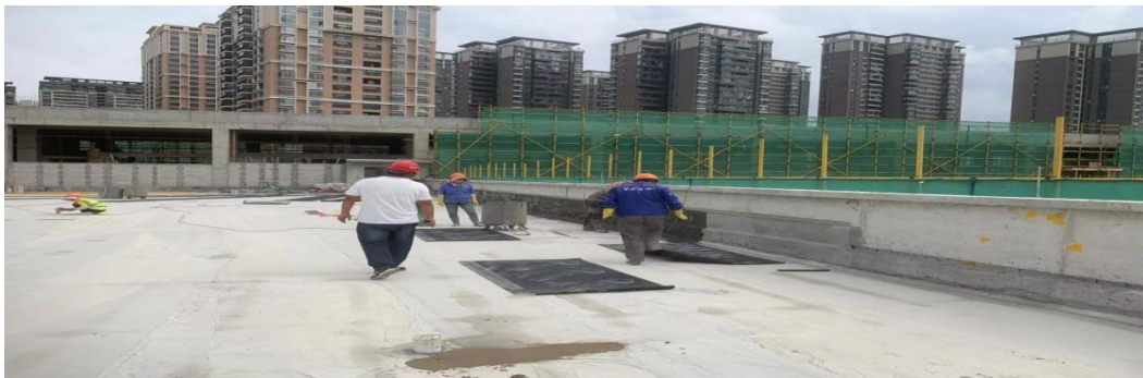
5#教学楼D区屋面层第二道防水铺粘
