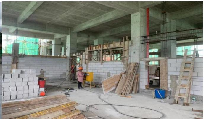
A区四层构造柱、过梁模板安装
