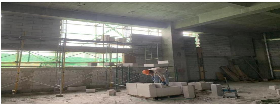
5#教学楼B区三层圈梁以上部分砖砌体砌筑
