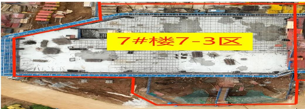
7#教学楼 二层外架完成，内支撑架、梁板支模完成50%
