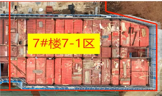
7-1区 二层外架完成，内支撑架、梁板支模完成
