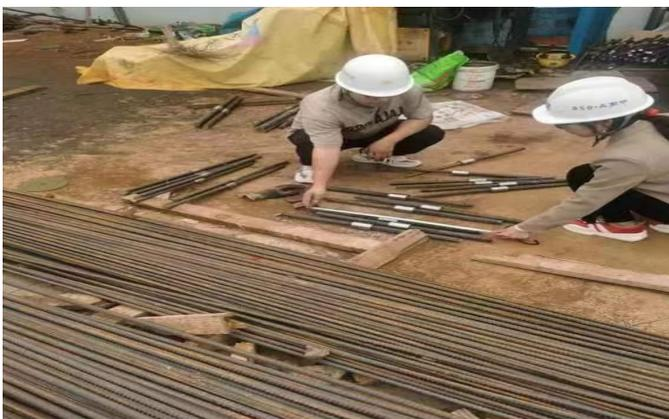
现场钢筋原材料取样抽检
