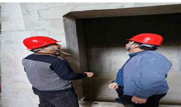
日常地下室巡检
