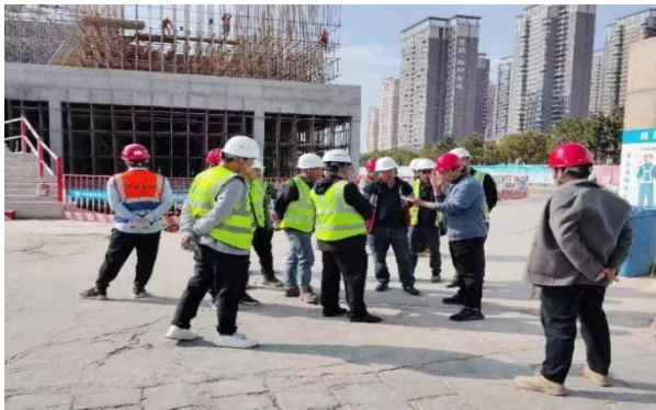
每周现场安全检查
