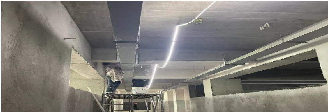
6#教学楼A区三层涂料施工
