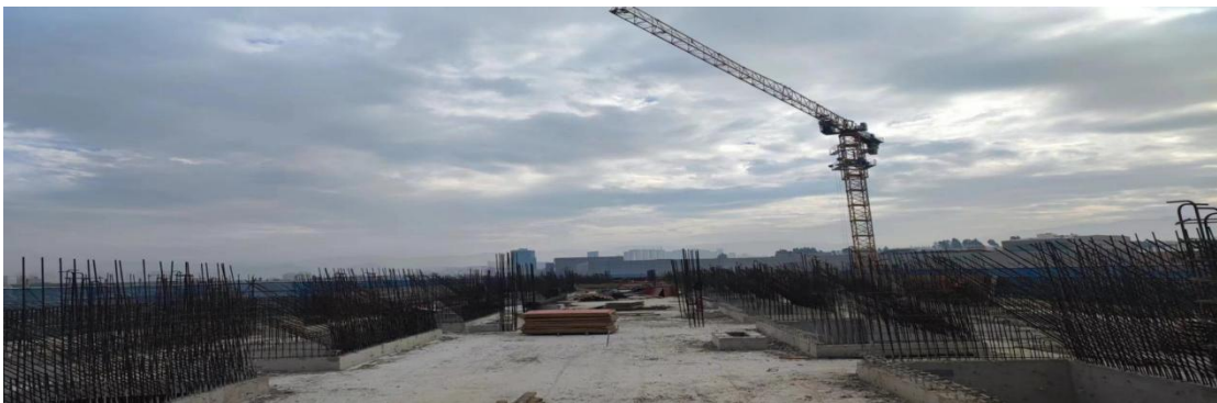
7#教学楼7-1区、7-2区、7-3区四层主体结构完成
