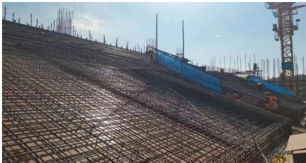
体育馆看台钢筋绑扎完成
