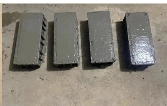
现场混凝土试块取样
