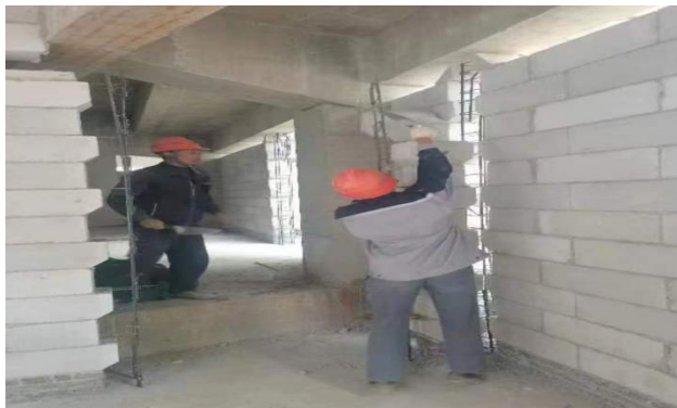
现场砌筑错台部位返工处理
