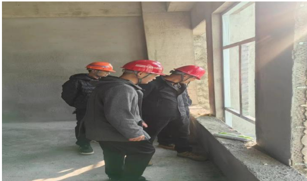
窗框安装样板复验
