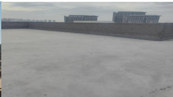
4#教学楼屋面刚性保护层施工完成
