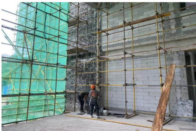
5#教学楼 C区、D区外墙面挂网拉毛
