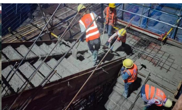
夜间浇筑巡检
