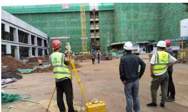
塔吊垂直度检查
