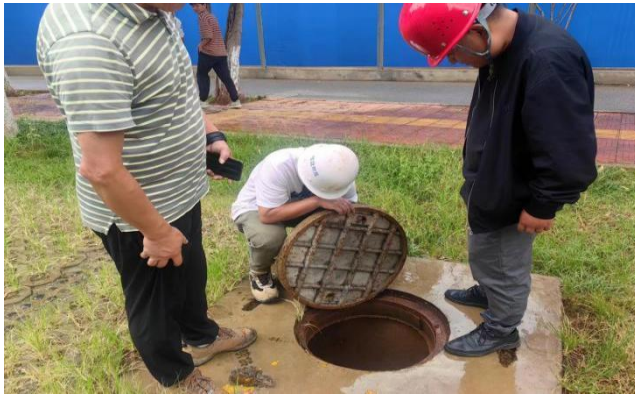
排查管道渗漏情况
