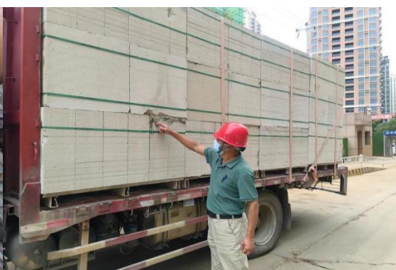
加砌块进场抽检
