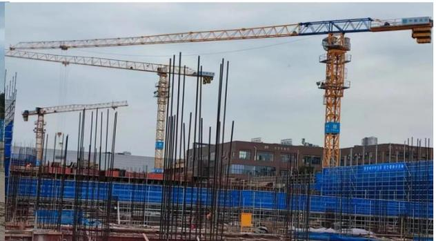
T-1区6米层梁钢筋绑扎完成，内支撑架，模板完成80%
