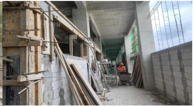
A区四层构造柱、过梁砼浇筑完成
