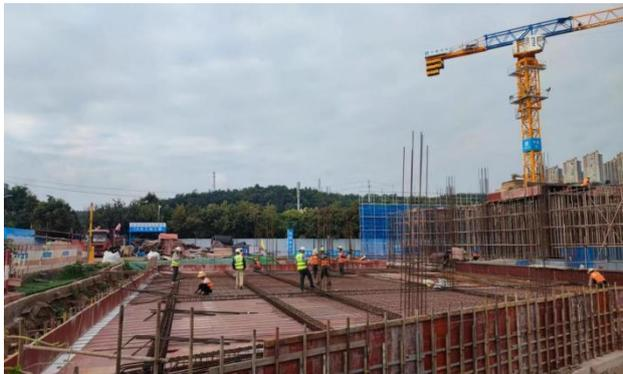
体育馆 T-3东侧-0.2米层钢筋绑扎完成
