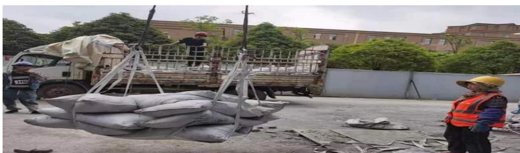
现场抹灰砂浆标识不清，原材进场材料不齐全撤场处理
