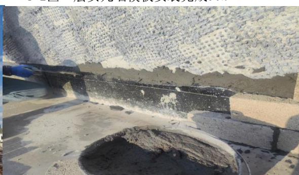
4#教学楼屋面防雷、屋面泛水保护层施工
