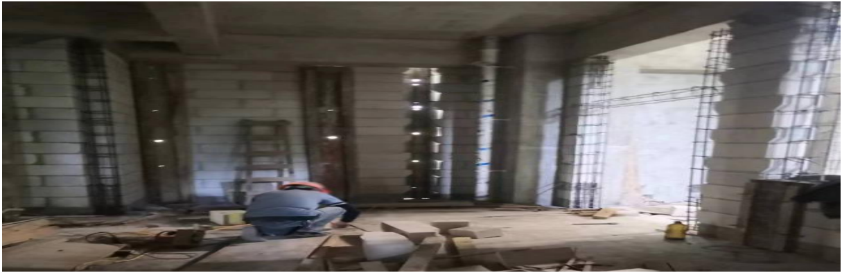
6#教学楼C区二层构造柱模板安装
