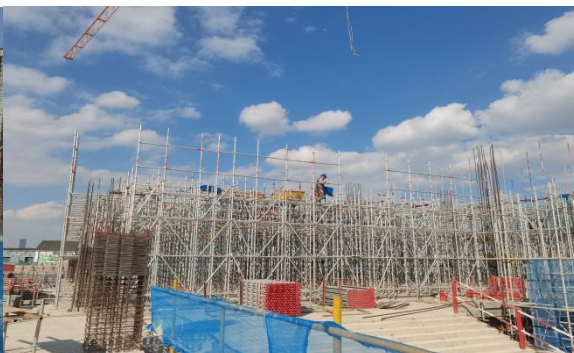
T-2区二层女儿墙模板安装完成90%
